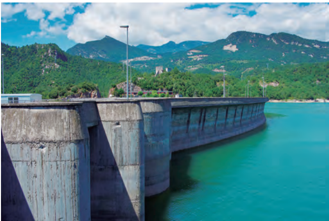
Paret de la presa del pantà de la Baells. (BO)
