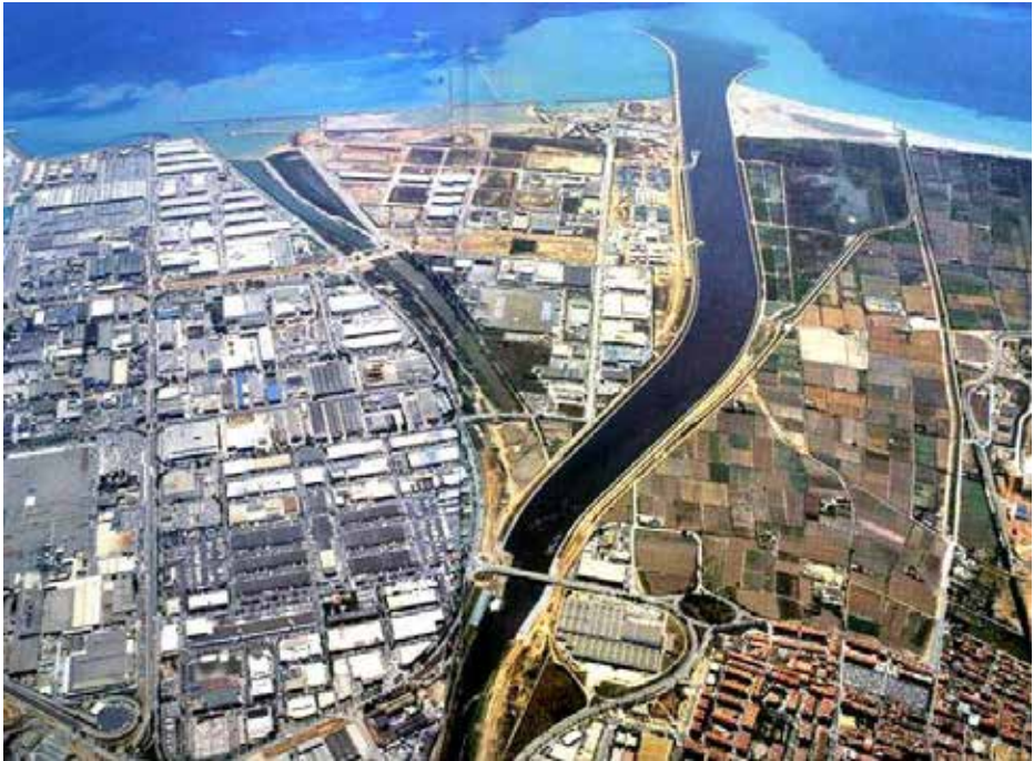
Desviació de la desembocadura del Llobregat realitzada el 2004 per permetre el creixement del port. Font: Centre d'Estudis de l'Hospitalet, 2005
