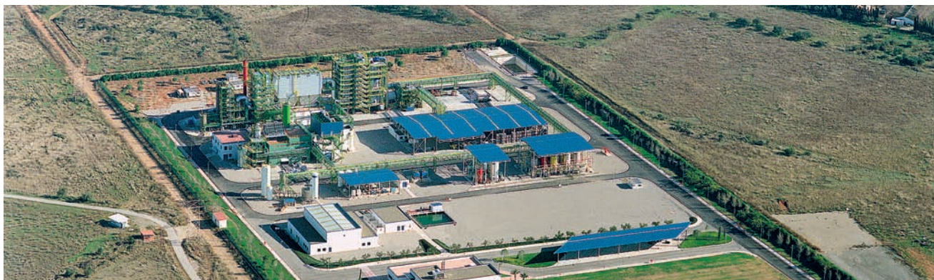
Planta incineradora de residus especials de Constantí.
