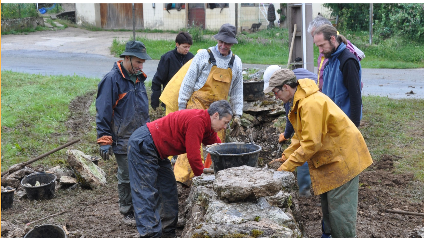
Figura 6. Creació d'un mur de pedra seca amb doble línia. França. Font: Poncetdespontets (CC BY-SA 4.0, sense canvis).
