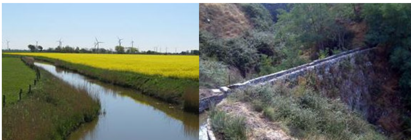
Figura 7. Exemple de dues sèquies diferents a Alemanya (esquerra) i Espanya (dreta). La sèquia de l'esquerra està constituïda per materials naturals i té marges amb un pendent suau i la de la dreta és artificial amb pendents de 90 °. Font esquerra: (CC BY-SA 3.0). Dreta: Javier Martin
